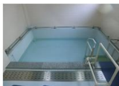
改修前(一般浴室)
